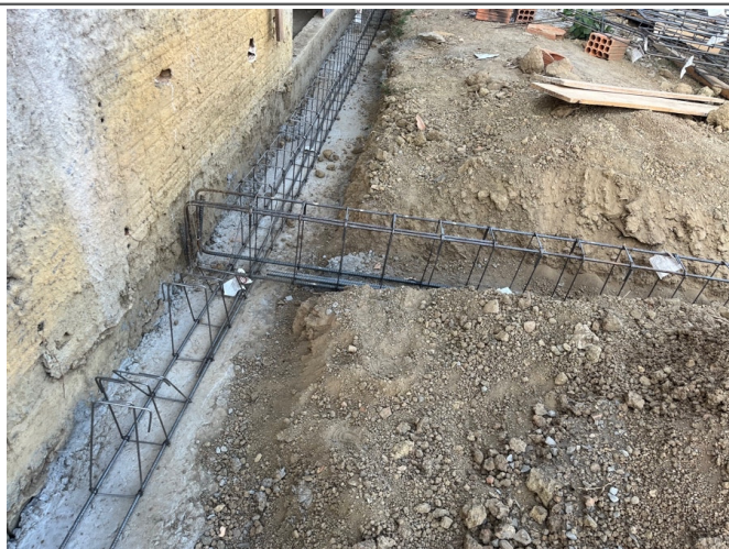
Armação e disposição das vigas baldrame.
