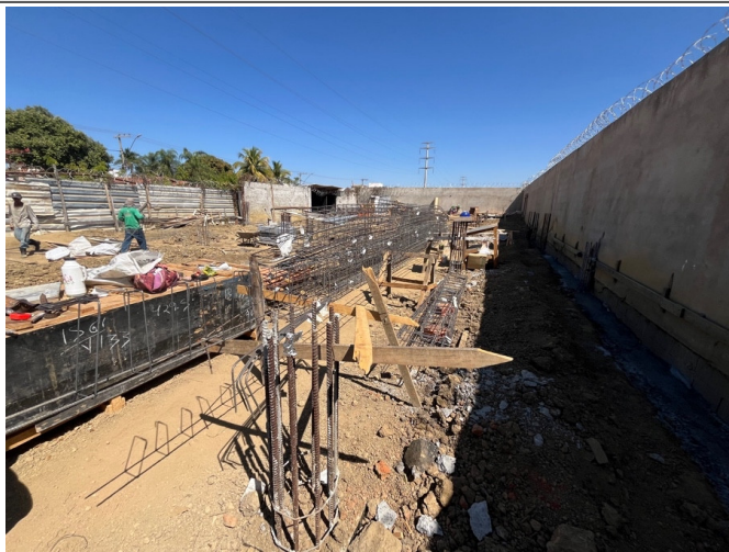
Armação e disposição das vigas baldrame.
