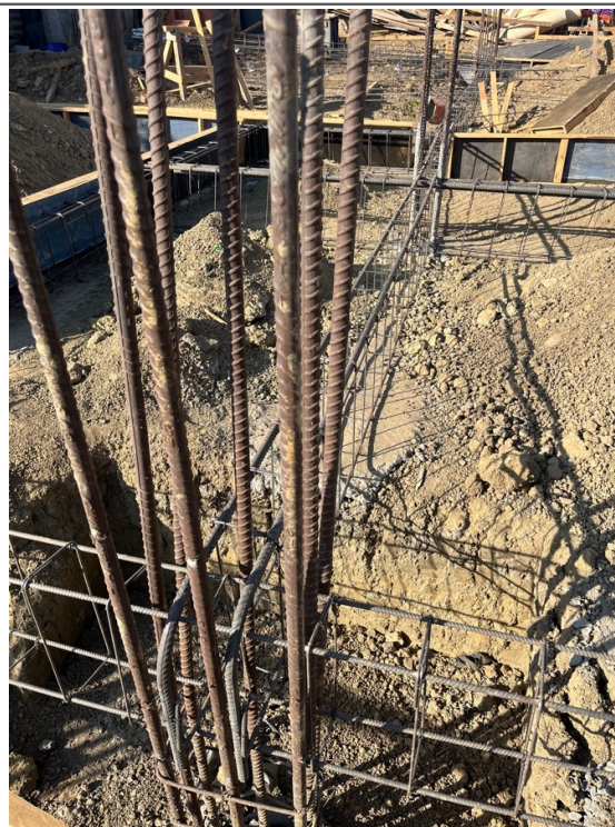
Armação e disposição das vigas baldrame.
