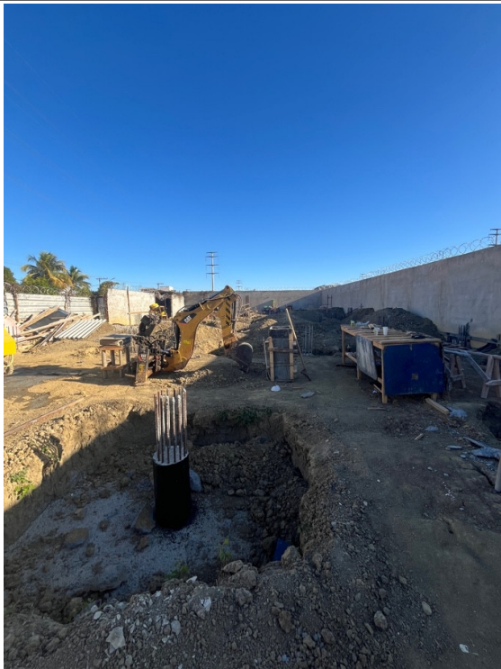
Impermeabilização dos pescoços de pilares.
