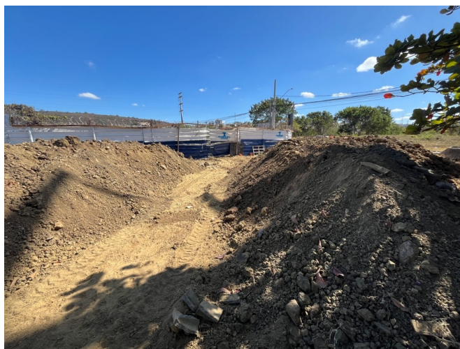
Regularização do terreno e limpeza
