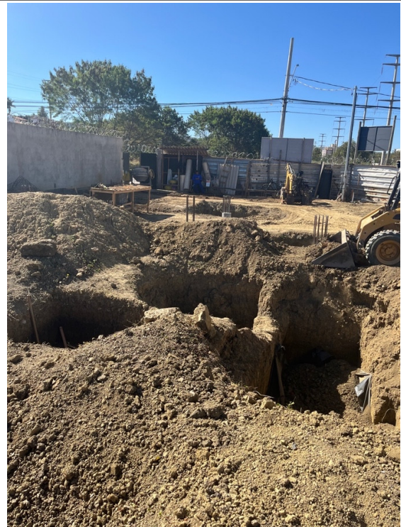
Escavação e concretagem das sapatas e pescocos das sapatas de fundação.
