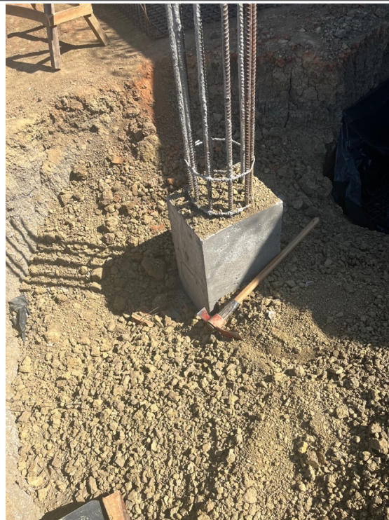
Escavação e concretagem das sapatas de fundação.
