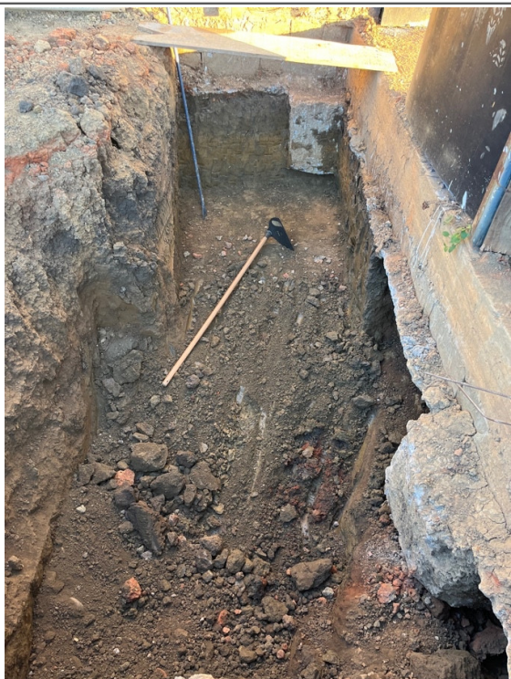
Escavação e concretagem das sapatas de fundação.
