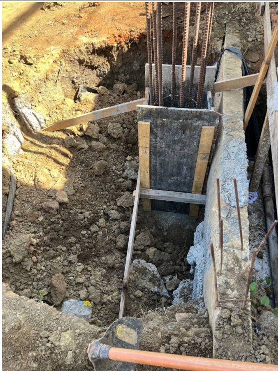
Escavação e concretagem das sapatas e pescocos das sapatas de fundação.
