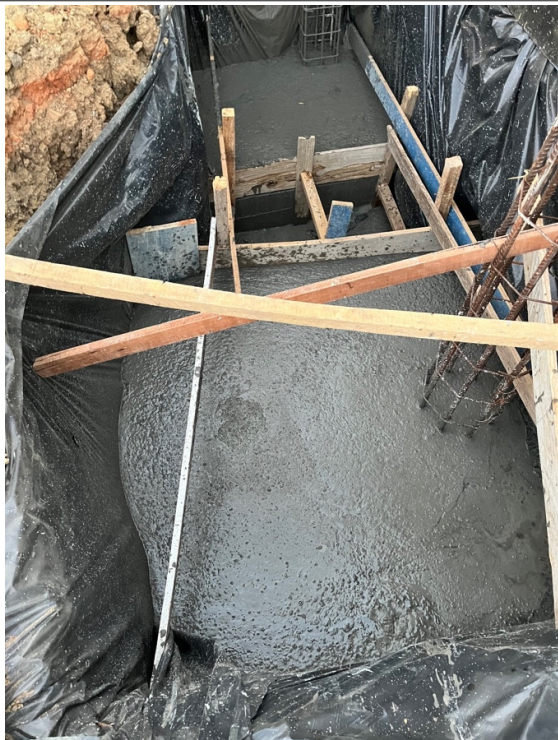
Escavação das sapatas de fundação.
