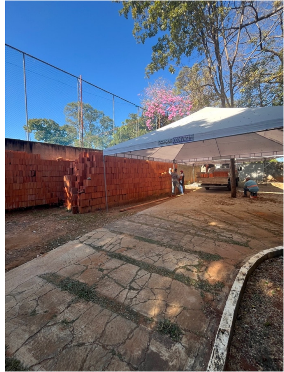
Transporte de tijolos.
