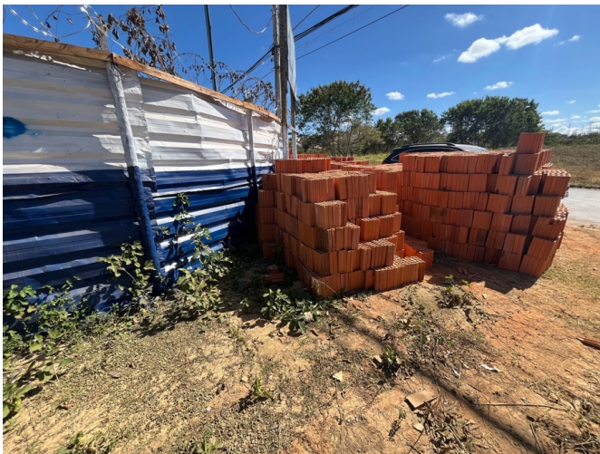
Transporte de tijolos.
