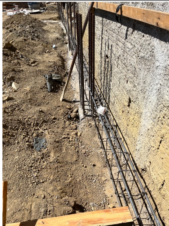
Armação e disposição das vigas baldrame.
