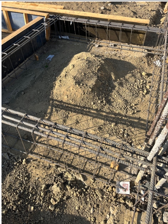
Armação e disposição das vigas baldrame.
