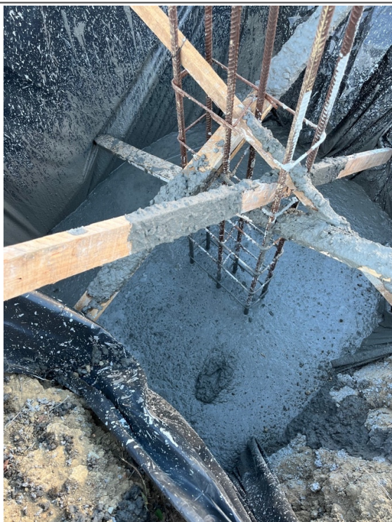
Escavação das sapatas de fundação.
