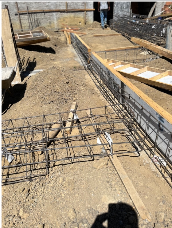
Armação e disposição das vigas baldrame.
