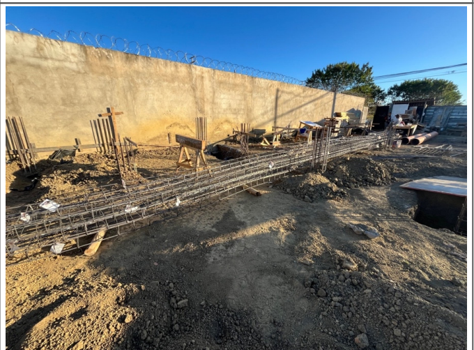
Armação e disposição das vigas baldrame.
