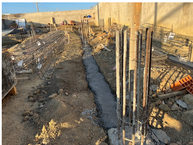
Armação e disposição das vigas baldrame.
