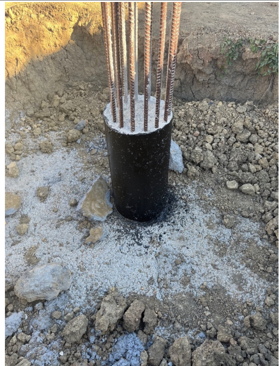
Impermeabilização dos pescoços de pilares.
