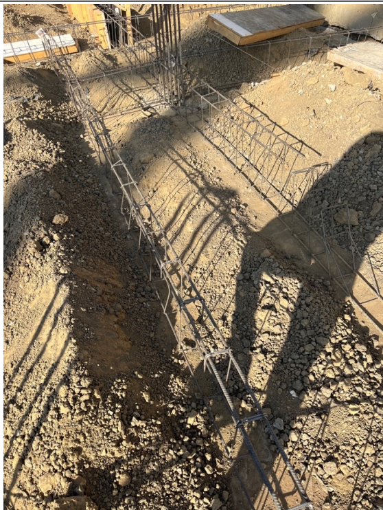
Armação e disposição das vigas baldrame.
