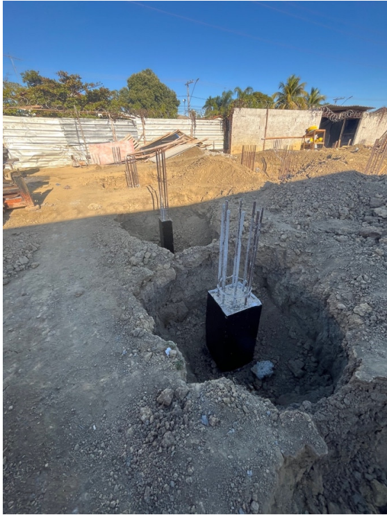
Impermeabilização dos pescoços de pilares.
