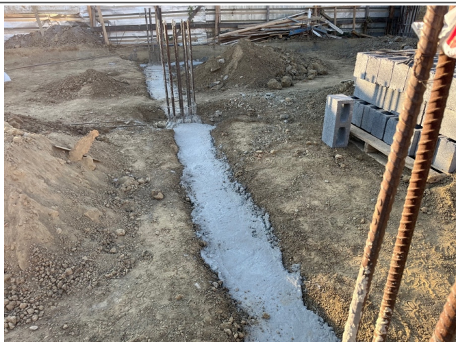
Armação e disposição das vigas baldrame.
