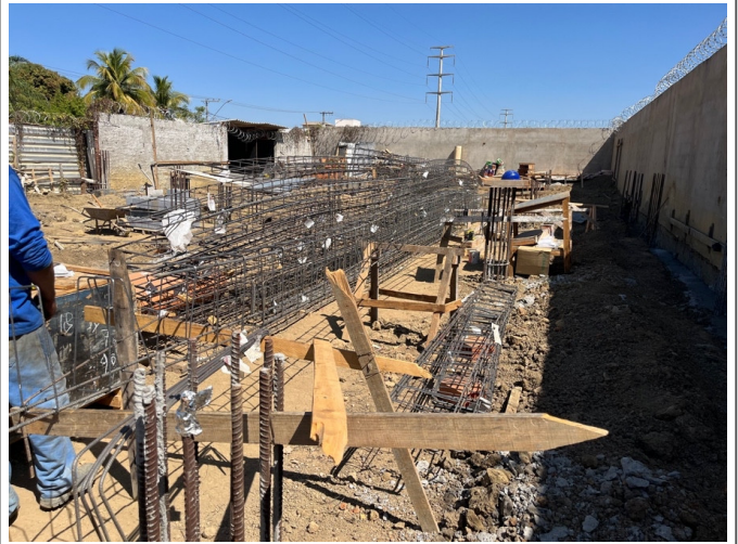
Armação e disposição das vigas baldrame.
