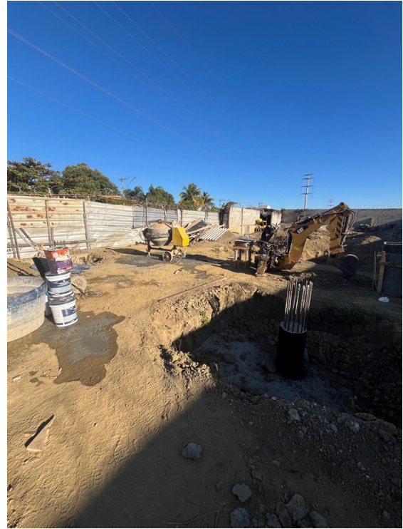
Impermeabilização dos pescoços de pilares.
