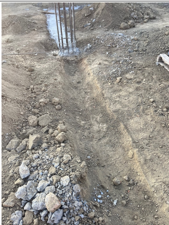
Armação e disposição das vigas baldrame.
