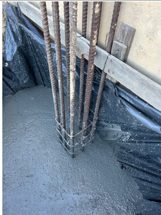
Escavação das sapatas de fundação.
