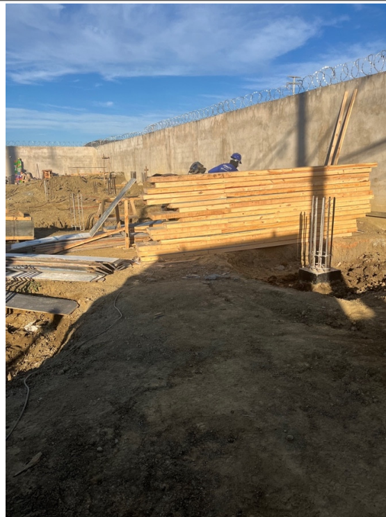
Forma para vigas Baldrame. Empresa: Logaste Construtora.
