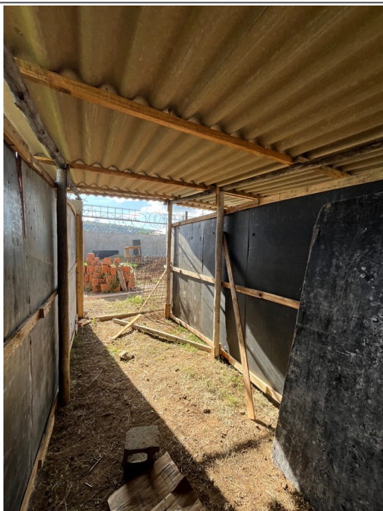
Pintura do Tapume e área de vivência. Empresa: Guilherme pintor.
