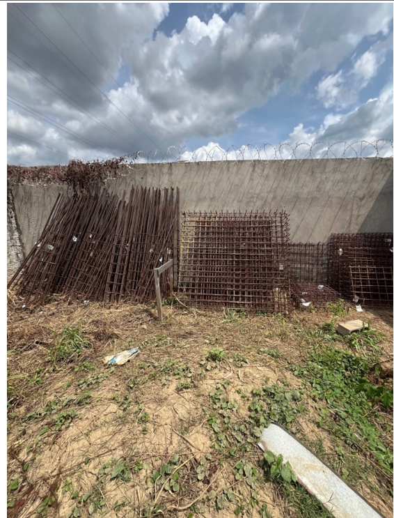
Escavação e concretagem das sapatas e pescoços de pilares da fundação.
