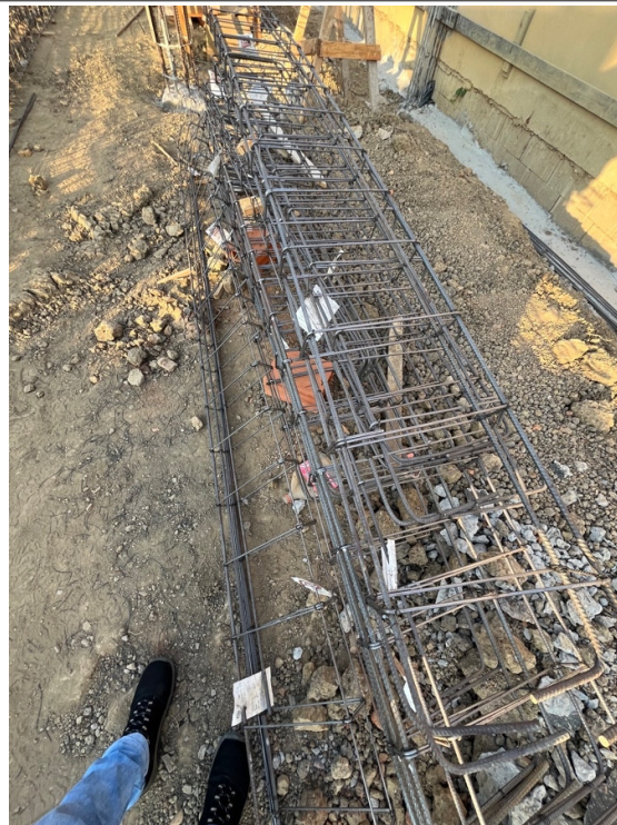
Armação e disposição das vigas baldrame.
