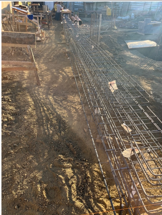
Armação e disposição das vigas baldrame.
