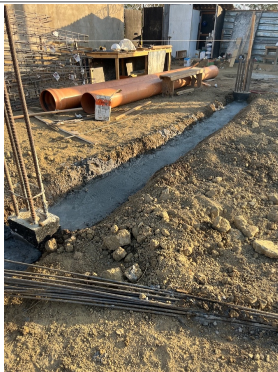
Armação e disposição das vigas baldrame.
