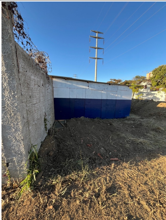
Regularização do terreno e limpeza no entorno Empresa: Turano Construtora.
