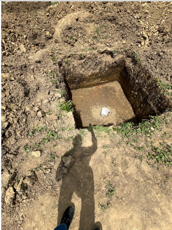
Escavação e concretagem das sapatas e pescoços de pilares da fundação.
