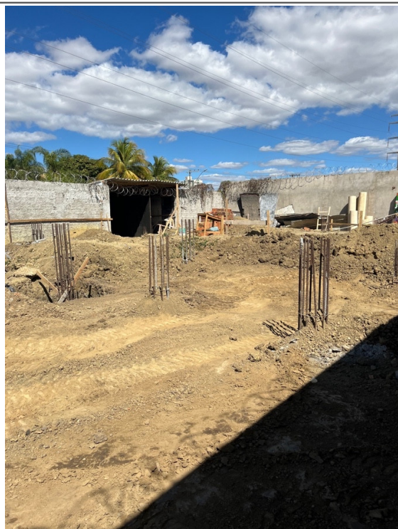
Regularização do terreno e limpeza no entorno d Empresa: Turano Construtora.
