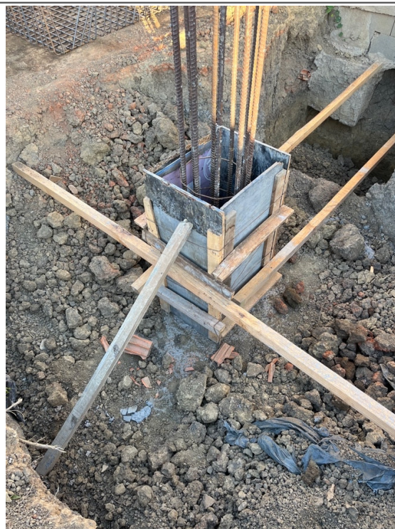
Escavação e concretagem das sapatas de fundação.
