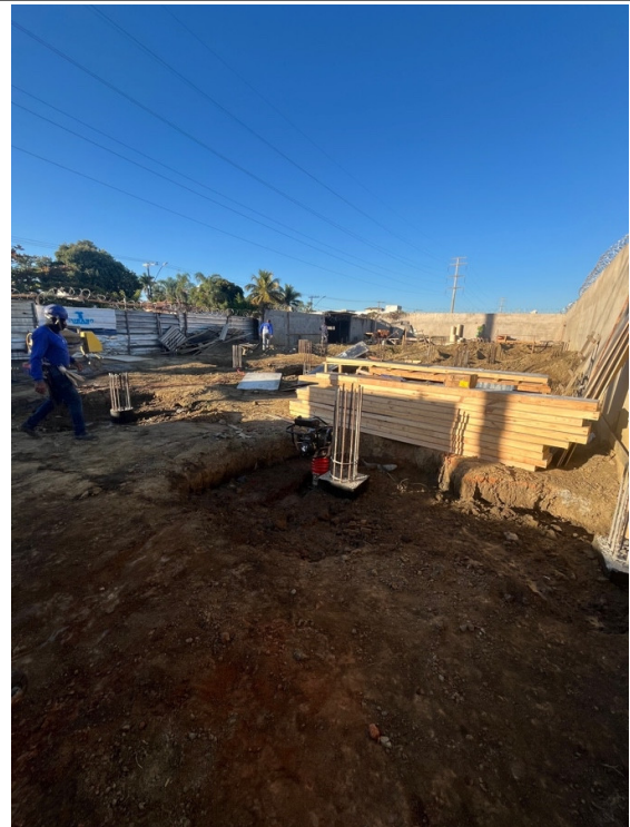
Forma para vigas Baldrame. Empresa: Logaste Construtora.
