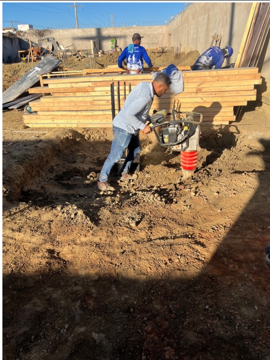
Forma para vigas Baldrame. Empresa: Logaste Construtora.
