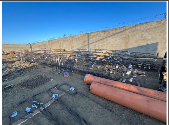
Armação e disposição das vigas baldrame.
