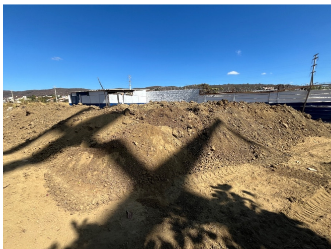
Regularização do terreno e limpeza no
