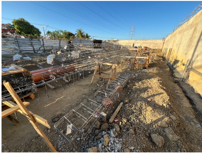
Armação e disposição das vigas baldrame.
