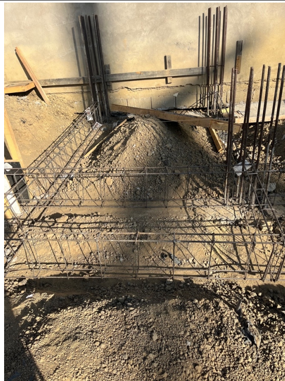
Armação e disposição das vigas baldrame.
