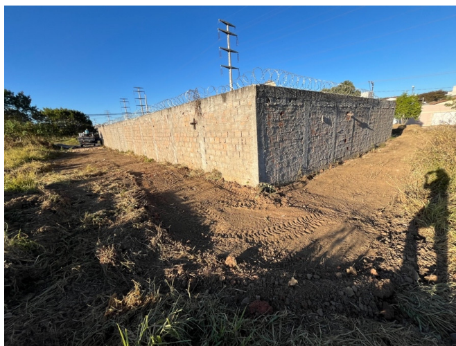
Regularização do terreno e limpeza no entorno Empresa: Turano Construtora.
