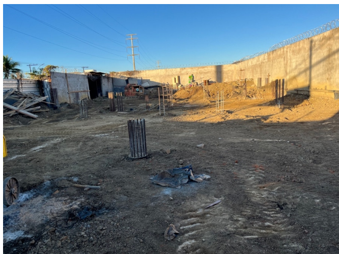
Regularização do terreno e limpeza no ent Empresa: Turano Construtora.
