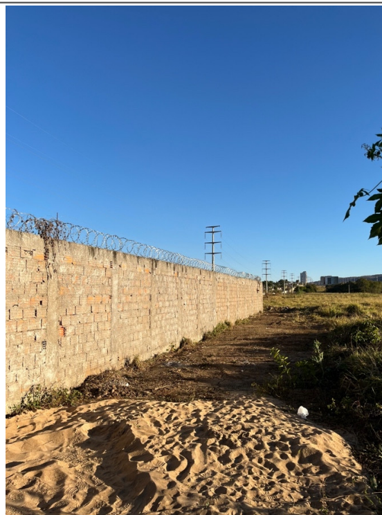
Regularização do terreno e limpeza no ent
