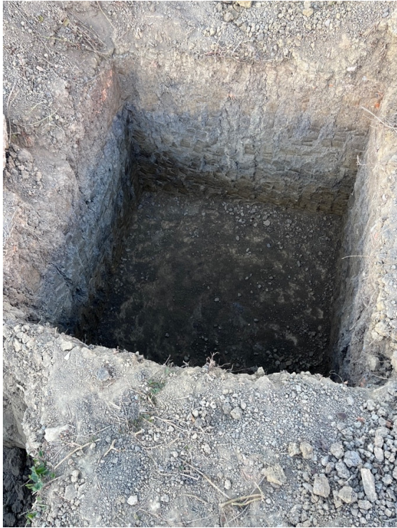
Escavação e concretagem das sapatas e das sapatas de fundação.
