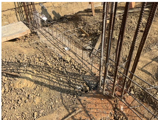
Armação e disposição das vigas baldrame.
