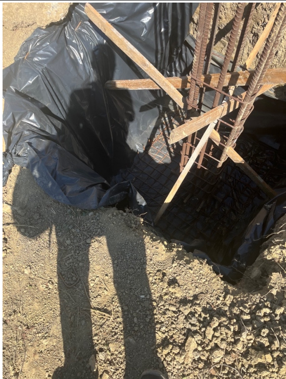
Escavação e concretagem das sapatas de fundação.
