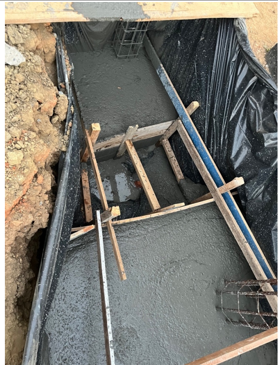
Escavação das sapatas de fundação.
