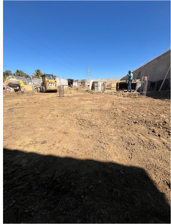
Regularização do terreno e limpeza no entorno da obra. Empresa: Turano Construtora.
