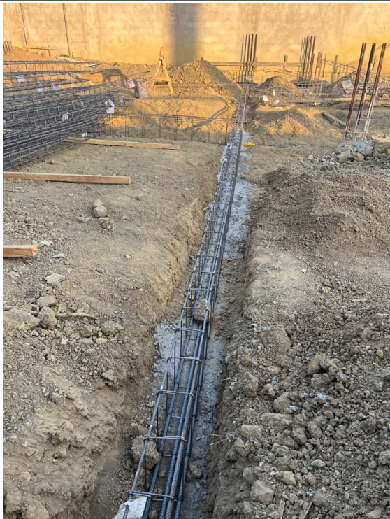
Armação e disposição das vigas baldrame.
