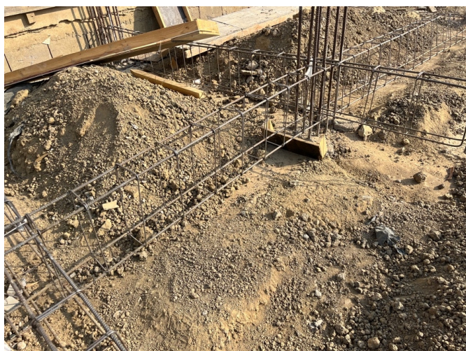
Armação e disposição das vigas baldrame.
