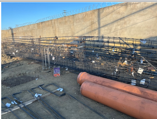
Armação e disposição das vigas baldrame.
