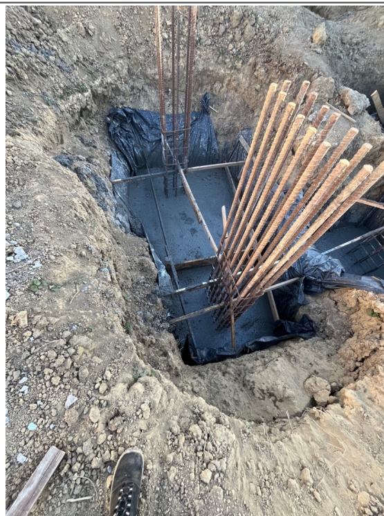
Escavação e das sapatas de fundação.
