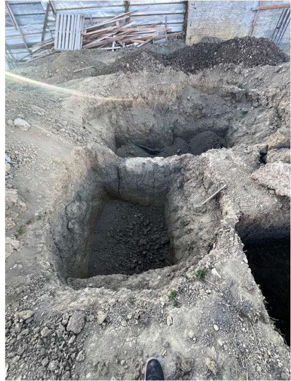
Escavação e concretagem das sapatas e pes das sapatas de fundação.
