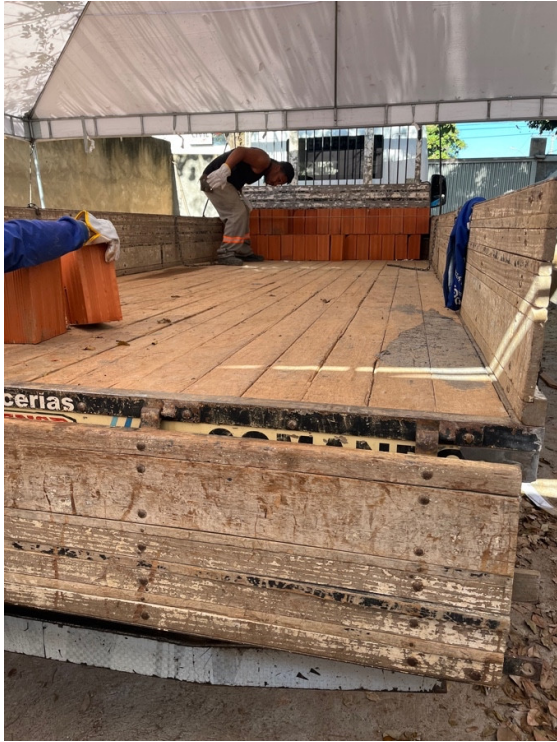
Transporte de tijolos.
