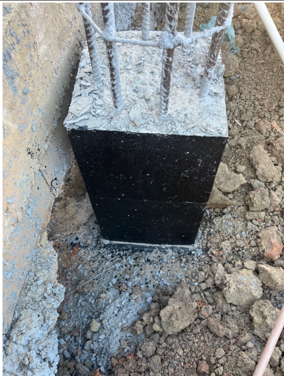
Impermeabilização dos pescoços de pilares.
